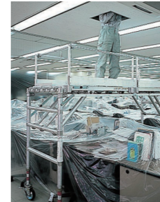
リニューアル足場
