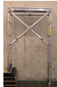
伸縮ジャッキで段差も解消
